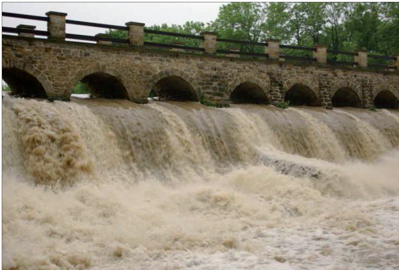
Obr. V.26 Bezpečnostní přeliv Počernického rybníka za povodně. Foto Magistrát hl. m. Prahy. Fig. V.26 The Počernice pond spillway during the flood. Photo Prague City Hall.
