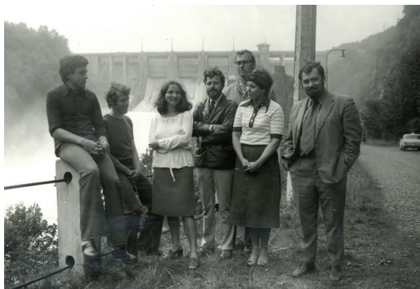
Obr. V.4 Pod Slapskou přehradou za povodně v roce 1977. Fig. V.4 Downstream of the Slapy water reservoir dam in 1977.
