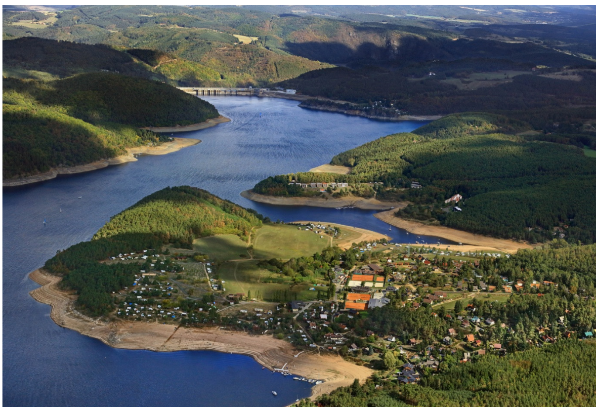
Obr. 9.14 Částečně vyprázdněná nádrž Orlík dne 27. 9. 2015 (Zdroj: Povodí Vltavy, s.p.).
