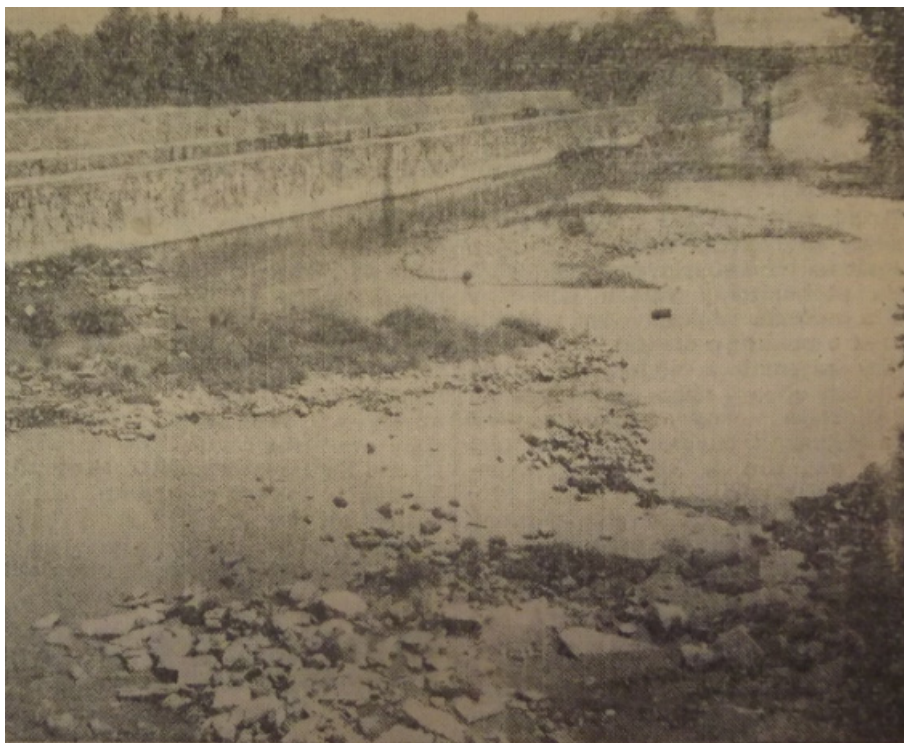
Obr. 10.6 Vltava mezi Hlávkovým mostem a Negrelliho viaduktem v září 1947 při průtoku cca 20 \text{ m}^3 \cdot \text{s}^{-1} (Foto: F. Sova, Svobodné slovo č. 217 ze 17. 9. 1947).
