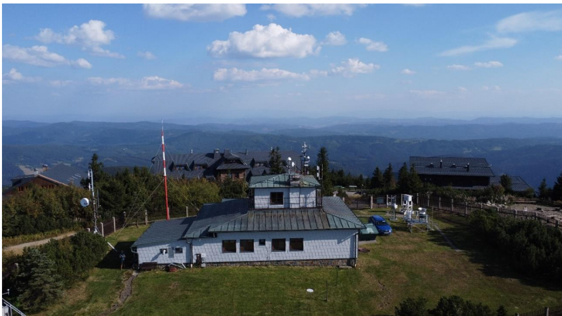
Obr. 21 Meteorologická stanice na Lysé hoře v září 2024. Foto: Pavel Lipina
