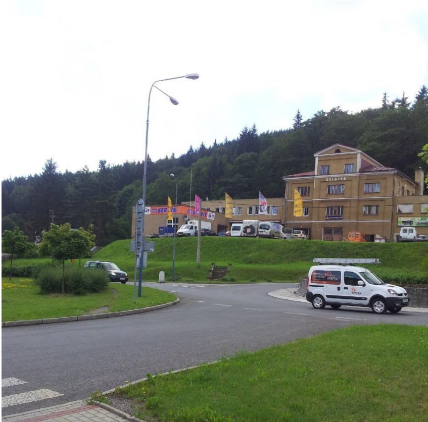
Obr. 52 Stanice Tanvald-Bálovka - celkový pohled.
