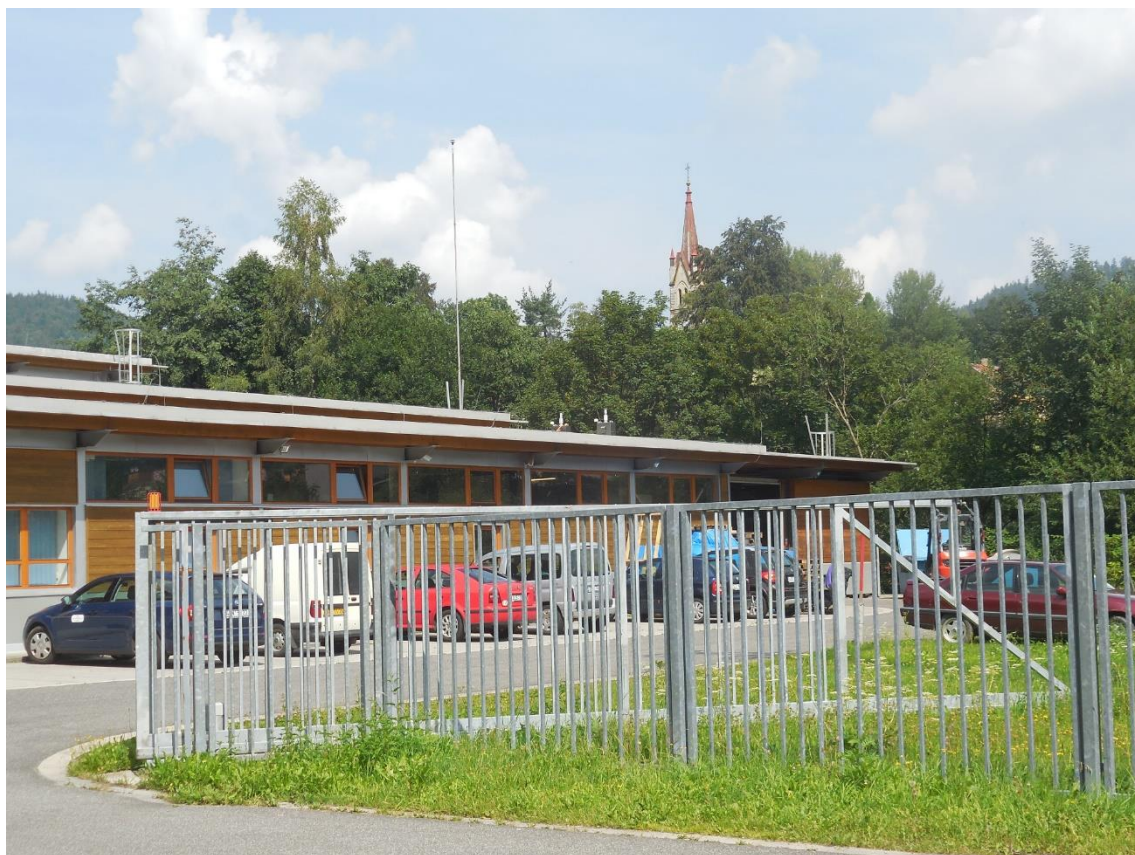
Obr. 48 Stanice Tanvald-Elšklo - celkový pohled.
