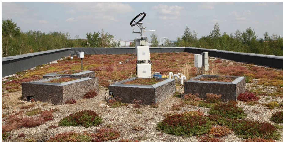
Obr. 1 Segmenty zelených střech na střeše budovy Univerzitního centra energeticky efektivních budov ČVUT v Praze. V pozadí meteorologická stanice (fotografie pořízena 15. července 2019).
