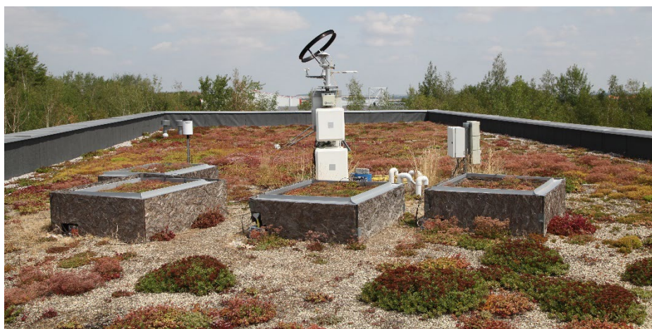
Obr. 1 Čtyři segmenty zelených střech na střeše budovy Univerzitního centra energeticky efektivních budov ČVUT v Praze. V pozadí meteorologická stanice (fotografie pořízena 15. července 2019).
