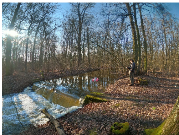
Obr. 22 Stavidlo obory Soutok (ČHMÚ, 4. 3. 2020)
