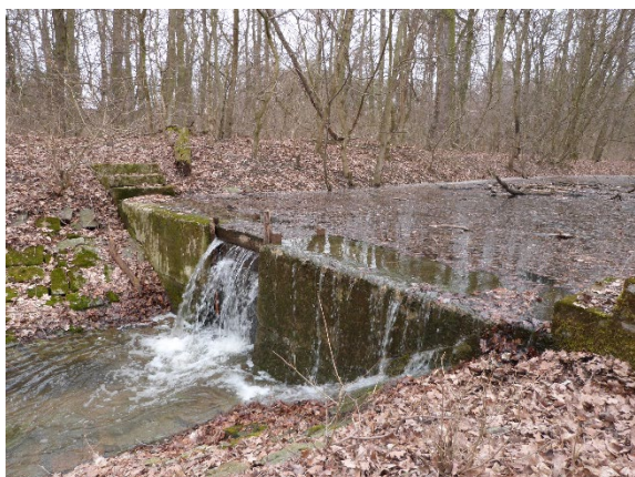
Obr. 21 Stavidlo obory Soutok (ČHMÚ, 8. 3. 2019)
