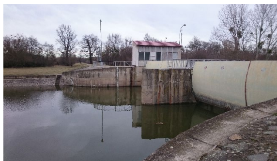
Obr. 20 Manipulační objekt pouštějící vodu z Dyje do obory Soutok (ČHMÚ, 8. 3. 2019)
