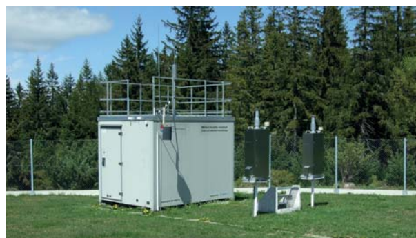
Obr. 2 Stanice CCHU-Churáňov, kontejner a dvě sekvenční odběrová zařízení (foto: ČHMÚ).
