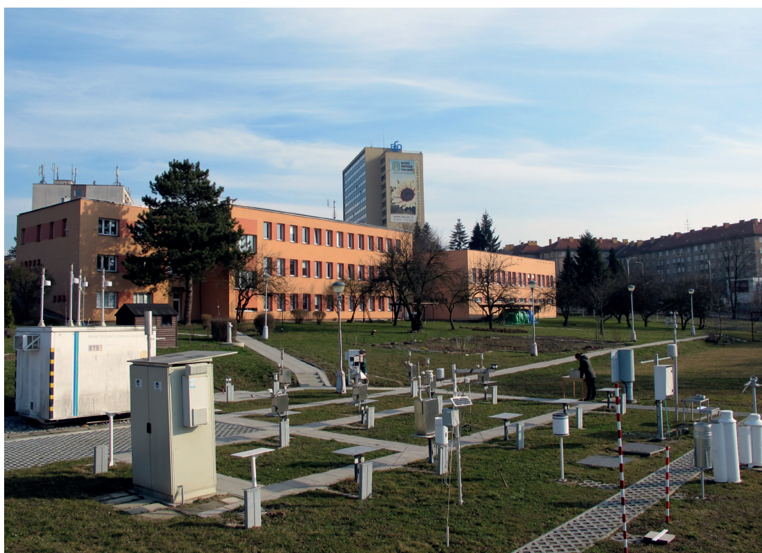
Obr. 3 Meteorologická zahrádka a měřicí pozemek pobočky, přelom 70. a 80. let a současnost.
