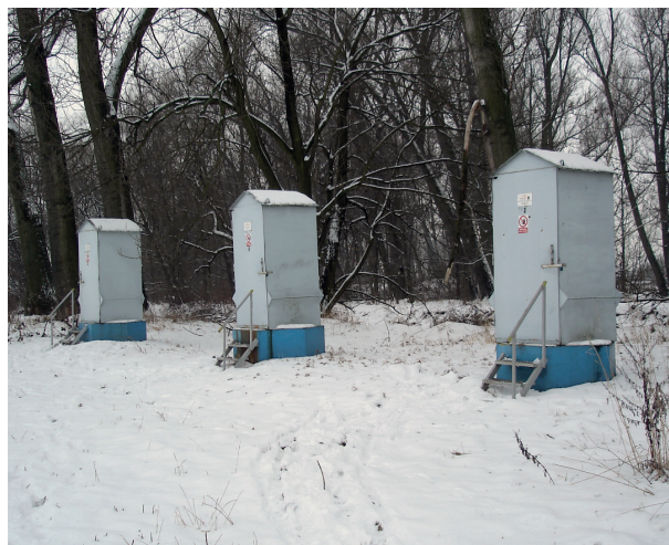
Obr. 25 Hluboký vrt pro pozorování hladiny podzemních vod Lukavice.
