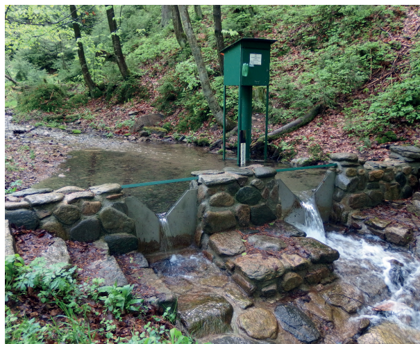
Obr. 26 Pramen v Dolní Moravě po rekonstrukci.
