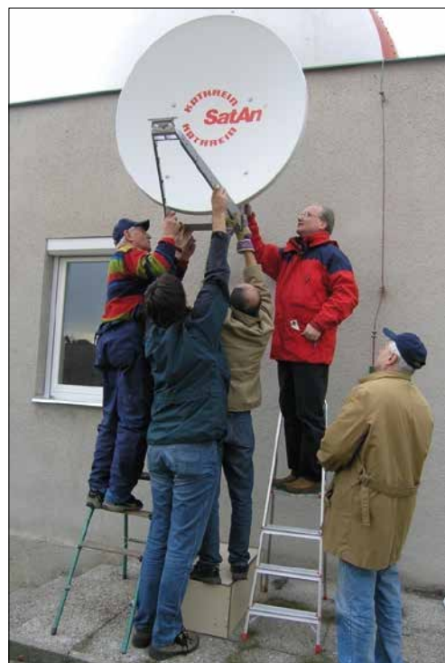
Obr. 6.9 Instalace přijímací antény pro MSG v prosinci 2004.
