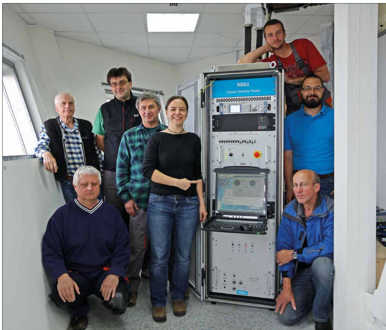
Obr. 4.11 Zaměstnanci odboru distančních měření a informací ČHMÚ podílející se na obnově meteorologických radarů CZRAD, společně s technikem výrobce u nově instalované skříně vysílače a přijímače radaru Vaisala WRM-200 na stanovišti Brdý.
