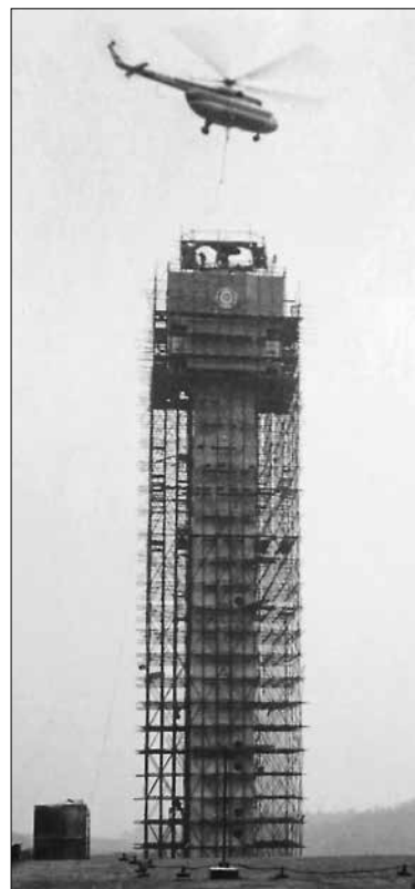
Obr. 4.3 Výstavba radarové věže na Observatoři Praha-Libuš. Základy pro věž (vlevo), instalace anténního systému radaru MRL-2 na vrchol věže (vpravo).
