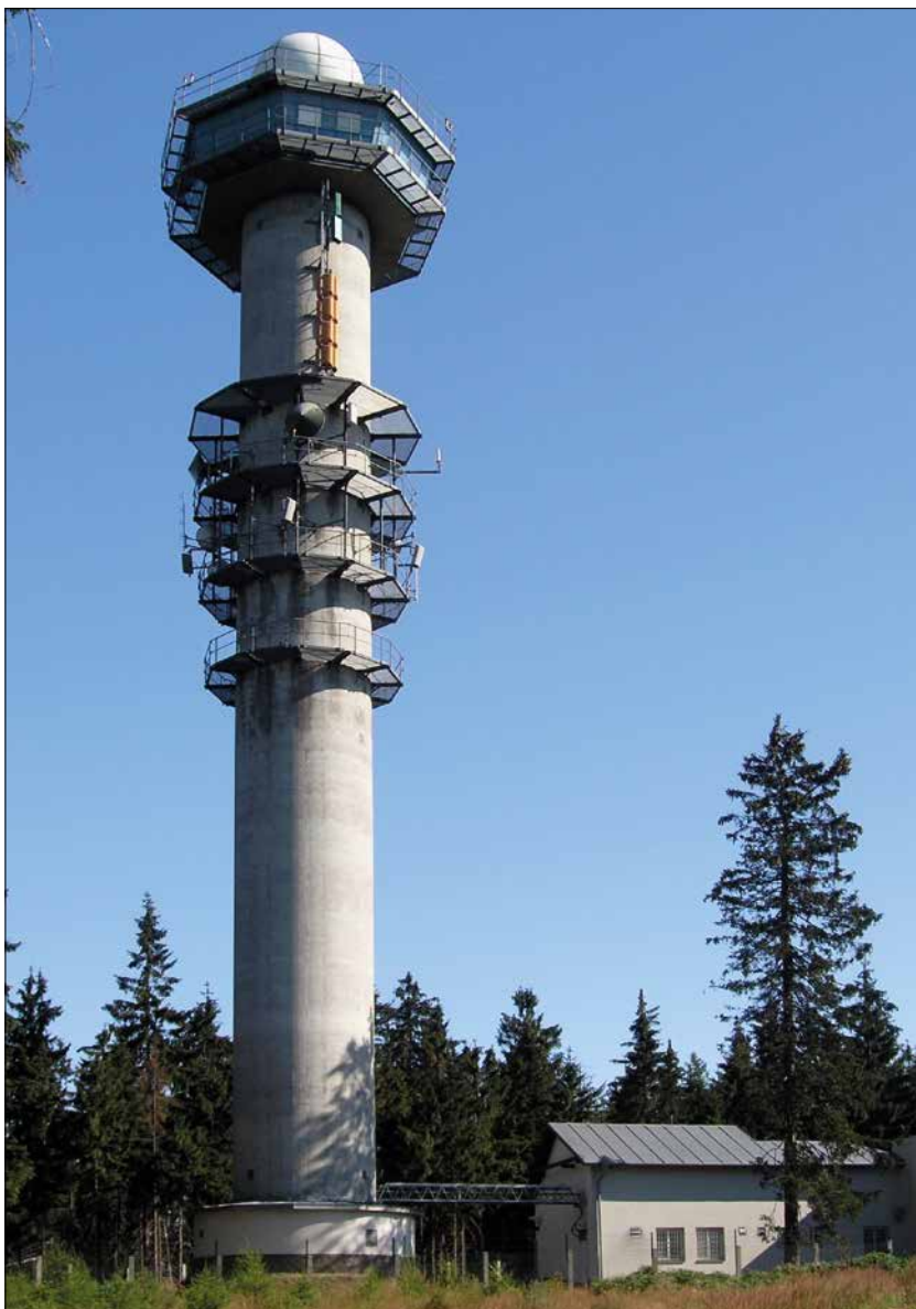
Obr. 4.8 Radarová stanice Brdy – kóta Praha s nově instalovaným radarem EEC DWSR-2500C.
