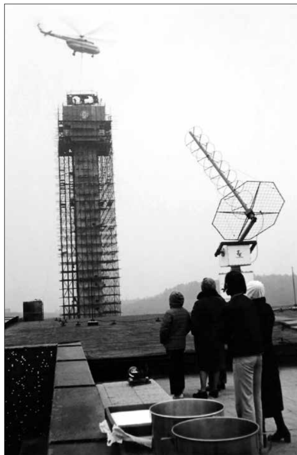
Obr. 1.6 Stavba šedesátimetrové radarové věže, v popředí družicová přijímací anténa.
