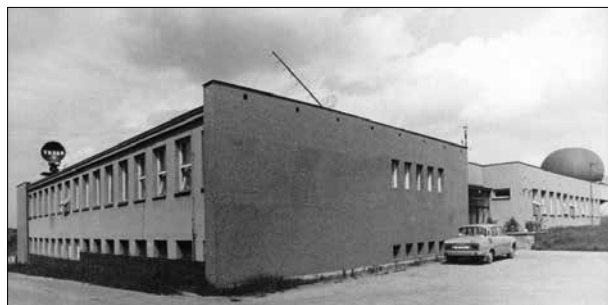
Obr. 4.1 Anténa radaru Tesla RM-2 (nahore) na střeše Observatoře Praha-Libuš (dole).
