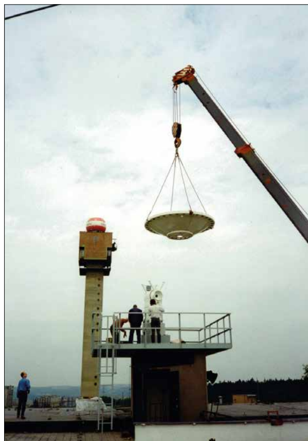
Obr. 6.7 Instalace systému pro příjem dat polárních družic v červnu 1995.
