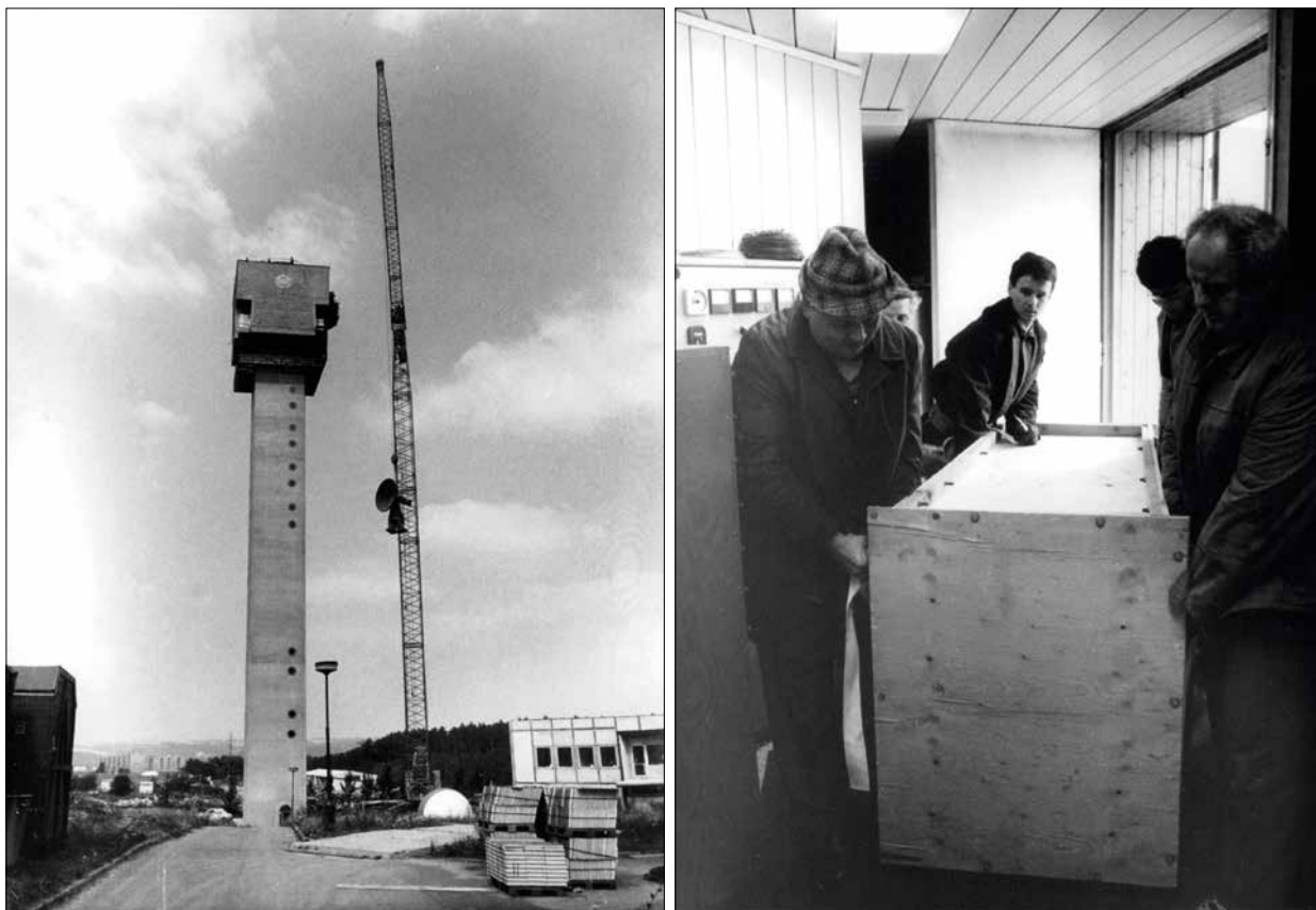
Obr. 4.5 Instalace radaru MRL-5. Výměna anténního systému (vlevo), přesun beden s novým radarem do radarové místnosti na věži radaru (vpravo), zleva doprava Václav Richter (tehdejší ředitel ČHMÚ), Pavel Karas, Jan Kráčmar a Radovan Petřík.
