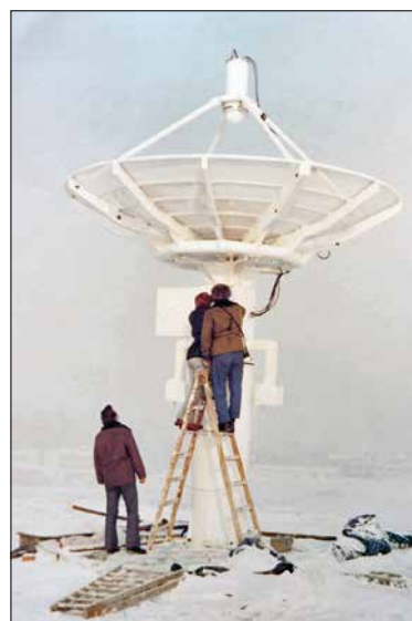
Obr. 6.4 Instalace digitálního systému MDA probíhala v lednu 1979 za mrazivého počasí.
