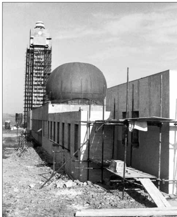
Obr. 1.7 Současně se stavbou věže byla přistavěna východní část hlavní budovy pro nový systém příjmu radio-sondážních dat.
