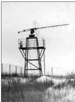
Obr. 6.1 Ještě před postavením budovy byla anténa pro příjem družicových dat umístěna na mírně vyvýšené konstrukci přímo na pozemku areálu.
