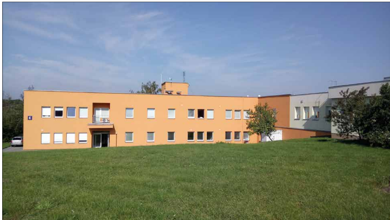
Obr. 10.1 Budova C je sídlem Oddělení přístrojové techniky a Metrologické kalibrační laboratoře. V přízemí vlevo je jídelna pro všechny zaměstnance Observatoře Libuš.
