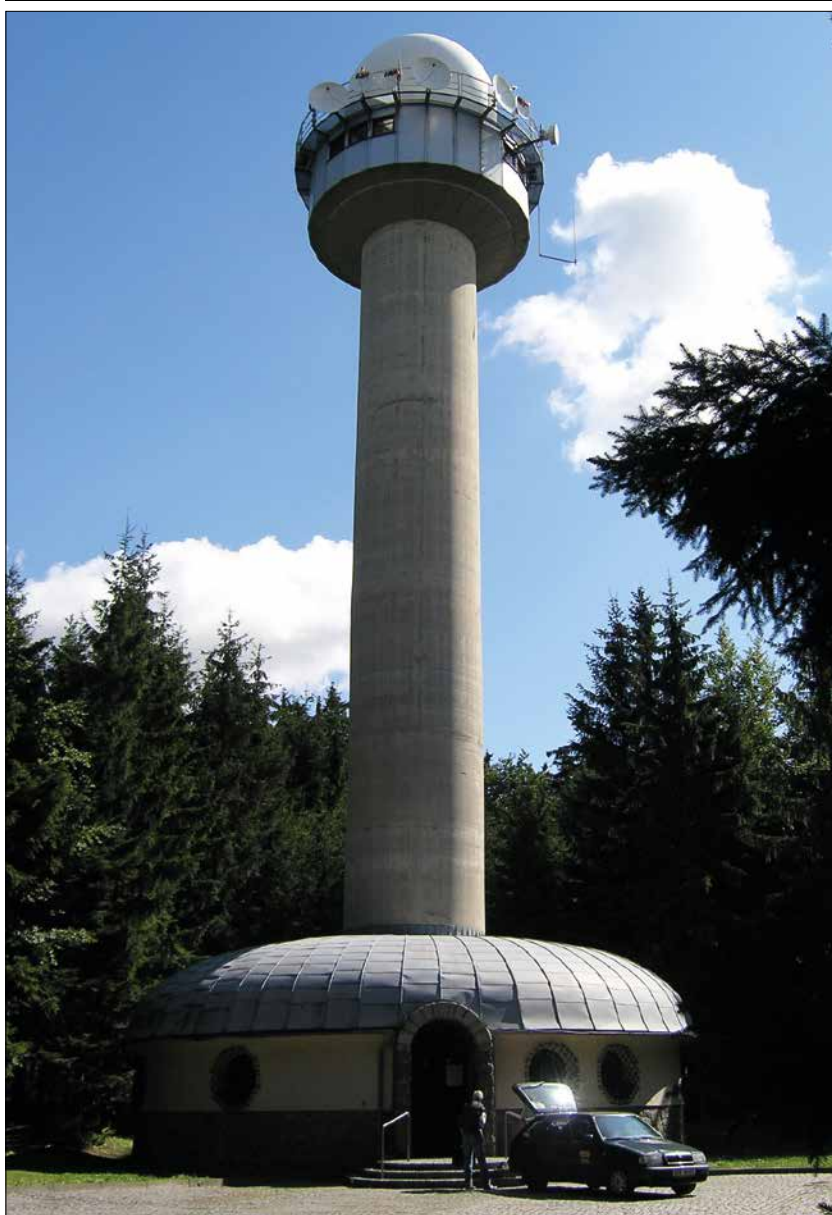
Obr. 4.7 Radarová stanice Skalky s nově instalovaným radarem Gematronik Meteor 360AC.
