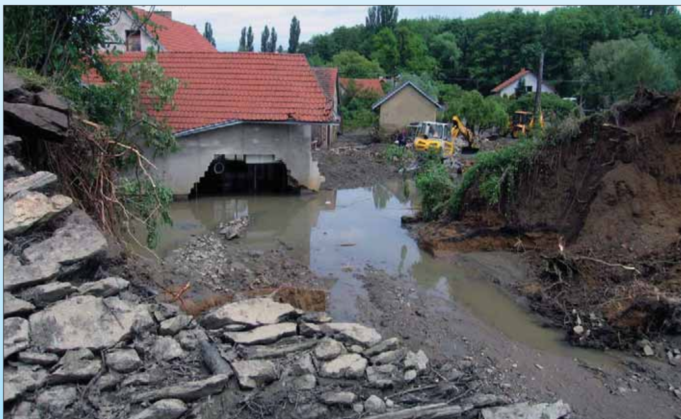
Obr. 4.14 Mlékovický rybník na Bečvárci – pohled průřvou do podhrází 5. 6. 2013 (Zdroj: VODNÍ DÍLA – TBD a. s.).
