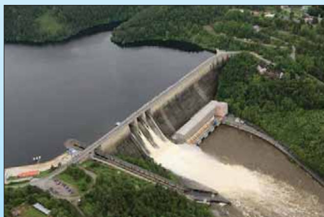
Obr. 4.4 VD Orlík – letecký pohled 4. 6. 2013 (Zdroj: Povodí Vltavy, s. p.).
