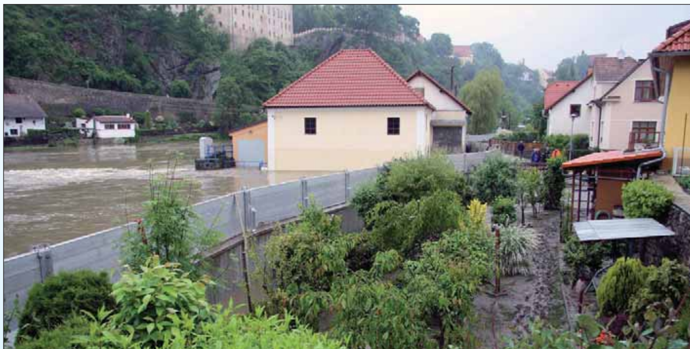
Obr. 4.17 Mobilní povodňové zábrany na Lužnici v Bechyni (Zdroj: VRV a. s.).
