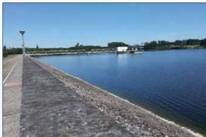
Obr. 4.7 VD Želivka – sdružený objekt se šachtovým přelivem (Zdroj: VODNÍ DÍLA – TBD a. s.).
