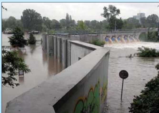
Obr. 4.20 Praha Libeň - přečerpávání vody z Rokytky (Zdroj: VRV a. s.).
