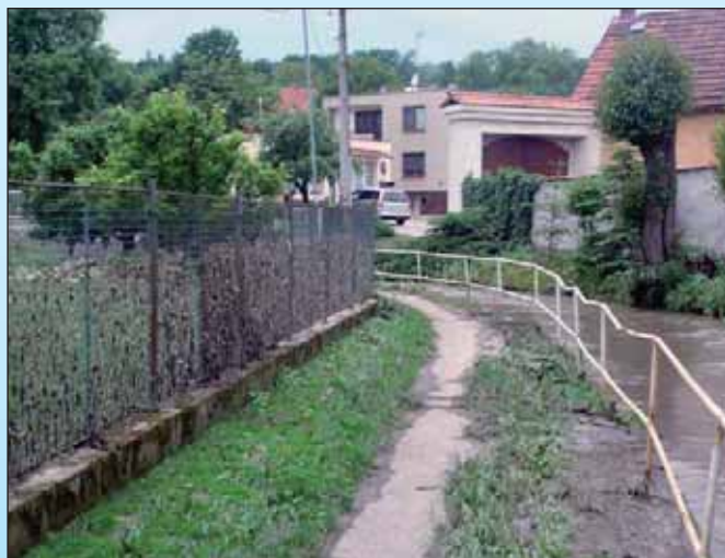
Obr. 2.3 Stopy kulminační hladiny po povodni v Bělokách na Dolanském potoce. (Zdroj: oficiální stránky obce Běloky).
