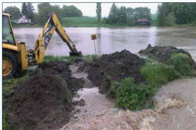
Obr. 4.13 Prohrábka boční hráze Chotouchovského rybníka na Polepce 2. 6. 2013 (Zdroj: VODNÍ DÍLA – TBD a. s.).
