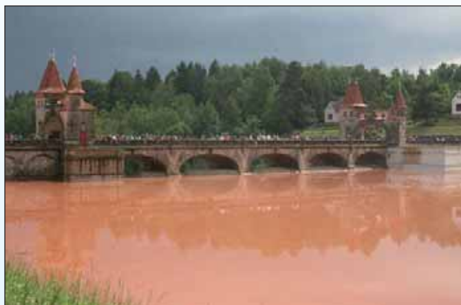
Obr. 4.9 VD Les Království – naplněná nádrž téměř po úroveň bezpečnostního přelivu (Zdroj: VODNÍ DÍLA – TBD a. s.).
