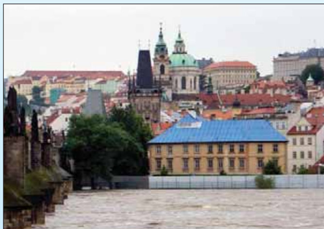
Obr. 4.18 Mobilní zábrany v Praze pod Karlovým mostem (foto Jan Kubát).
