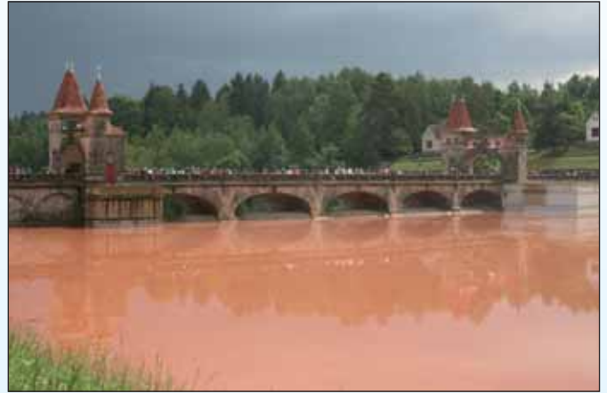
Fig. 4.9 Les Království Reservoir – Reservoir Filled up to Safety Spillway Level (Source: VODNÍ DÍLA – TBD a. s.).
