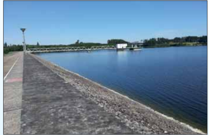
Fig. 4.7 Švihov Reservoir – Combined Structure with Shaft Spillway (Source: VODNÍ DÍLA – TBD a. s.).
