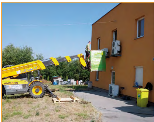
Navážení klimatické komory dodavatelskou firmou k instalaci do prostorů kalibrační laboratoře.
