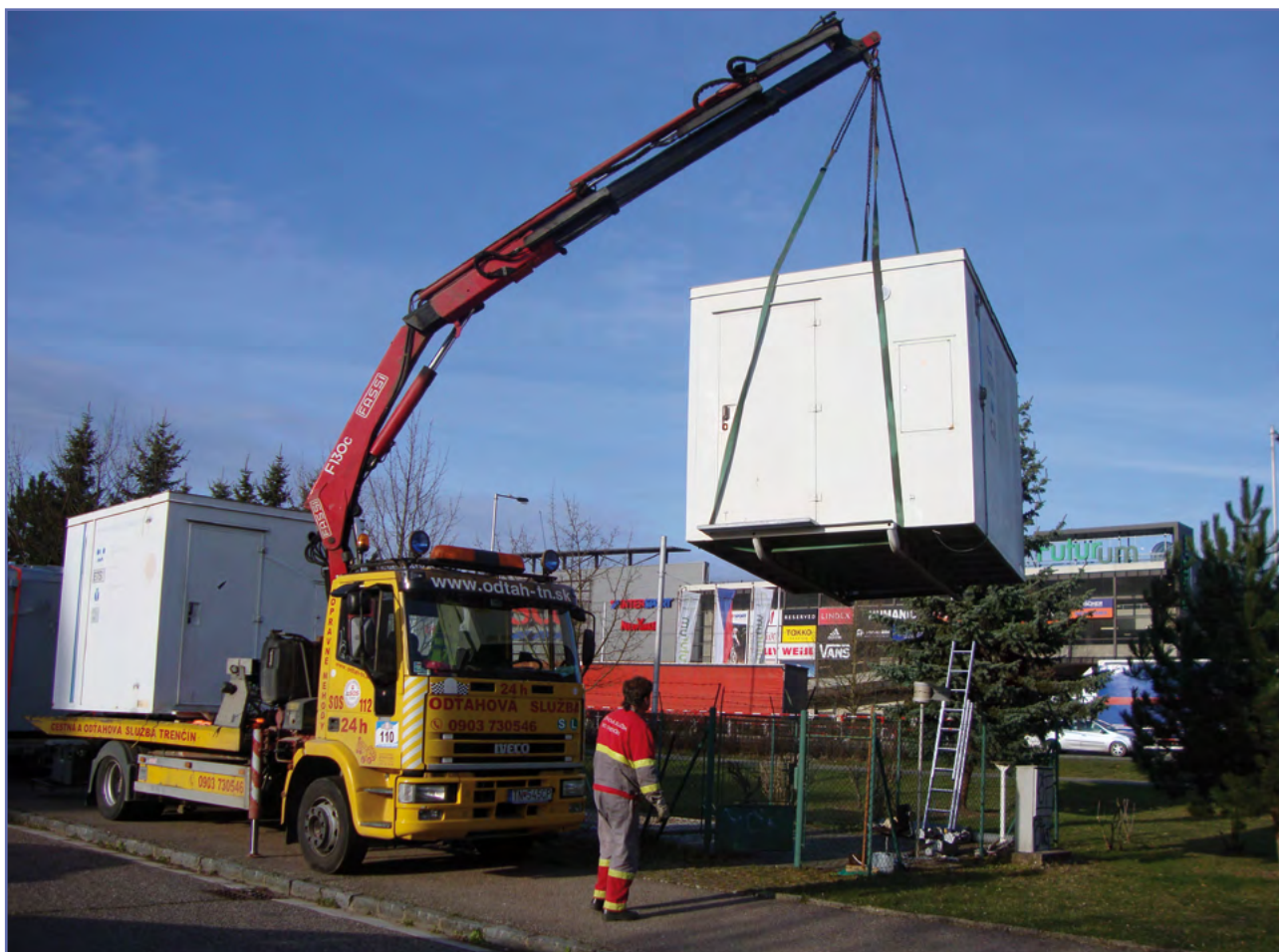
Výměna kontejneru na lokalitě Hradec Králové – Brněnská. Container replacement at the Hradec Králové, Brněnská Street site .
