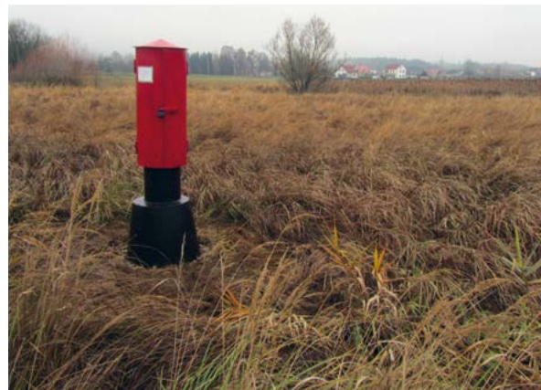
Oprava nadzemní části vrtu, Pávov. Repair of the surface plant of a borehole, Pávov.
